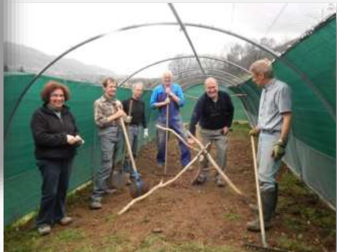
Fin du chantier sécurisation volière à passereaux. Photo Tichodrome.
