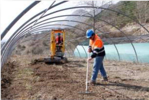
Terrassement de la volière 28m avec l'aide de la société VICAT. Photo Grégory Berger.
